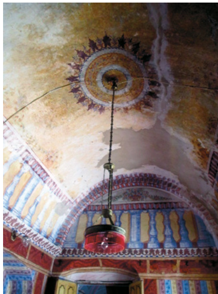
Bóveda de cañón
