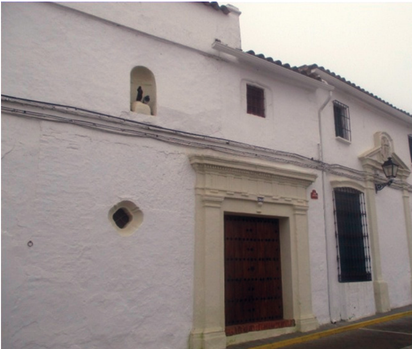
Exterior de la capilla en la calle Feria, hoy Juan Carlos I
